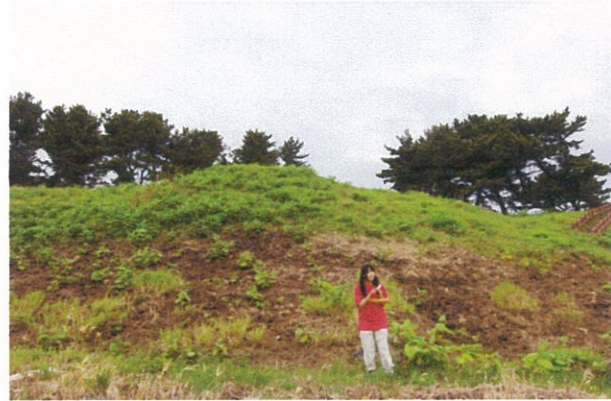
写真4 津波による海面上昇の跡（草が生えない）
