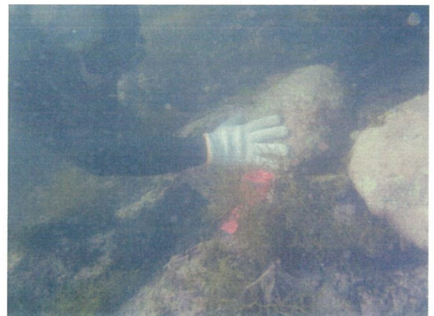
写真4 海底へ海藻を培養した石の設置作業の様子。
