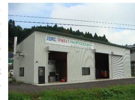
バイオマスボイラー(かつばのゆ)
