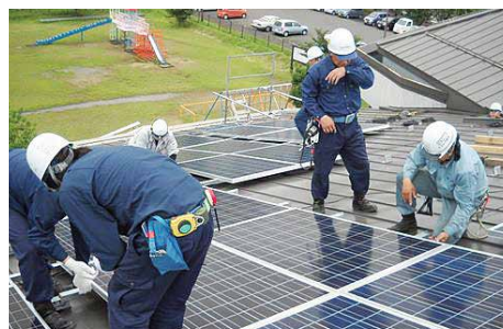
太陽光パネル設置の様子
