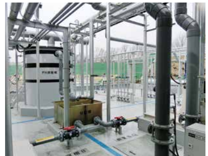
管理型最終処分場 水処理施設
